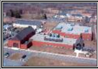
McAfee Center (Building 600)
